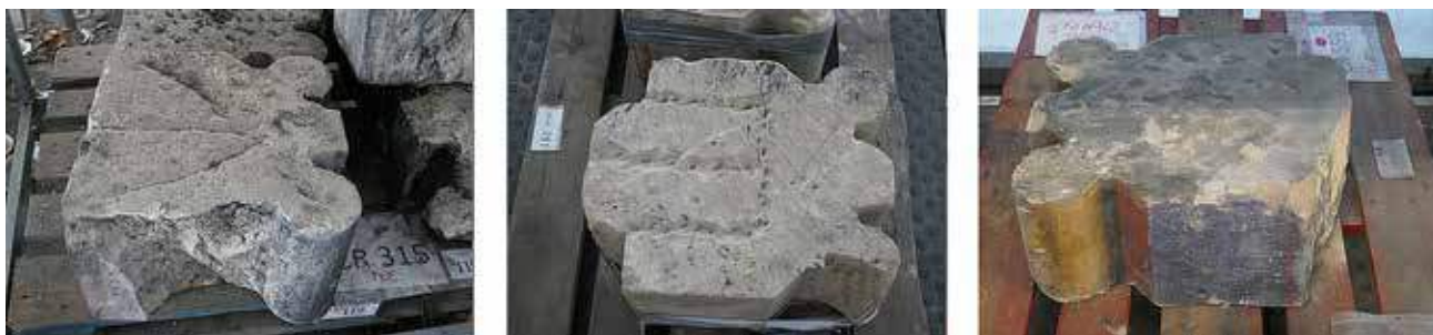
Figure 12 Trois claveaux des XVIII e et XIX e siècles provenant de la croisée du transept de Notre-Dame de Paris : abreuvoirs en patte d'oie, en trident et avec un piquetage, Île-de-France, juillet 2020. © Bruno Phalip (CHEC).
