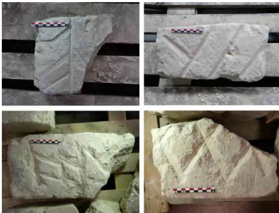
Figure 11 Différents types d'abreuvoirs observés sur les voussoirs du premier quart du XIII e siècle de la nef de Notre-Dame de Paris, Île-de-France, mai 2023. © Élise Baillieul (HARTIS).
